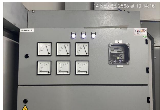
ภาพที่ 2-14 มิเตอร์ไฟฟ้าสำหรับบำบัดน้ำเสีย
