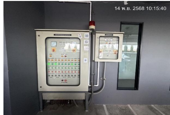
ภาพที่ 2-10 ระบบบำบัดน้ำเสีย
