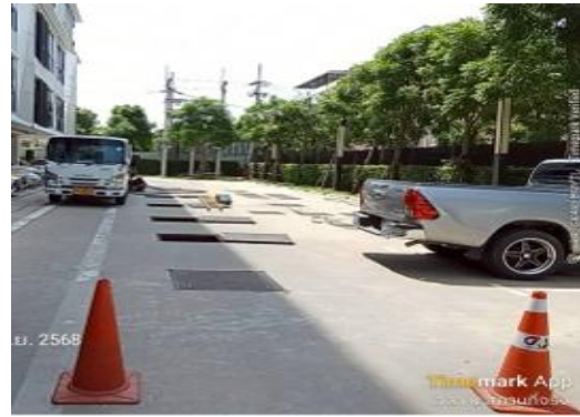
ภาพที่ 2-23 การนำกรวยตั้งบริเวณฝาท่อกรณีที่มี การบำรุงรักษา
